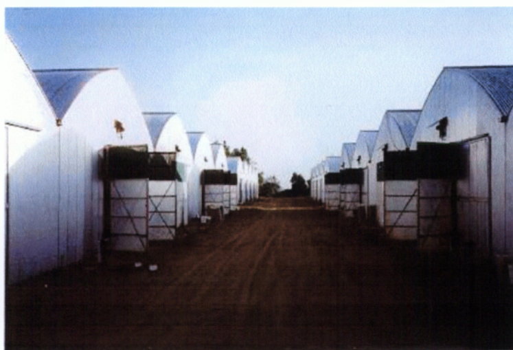
Εικόνα 8. Κλειστοί χώροι ελεγχόμενου περιβάλλοντος όπου τοποθετούνται οι κορμοί για καλλιέργεια του μύκητα
