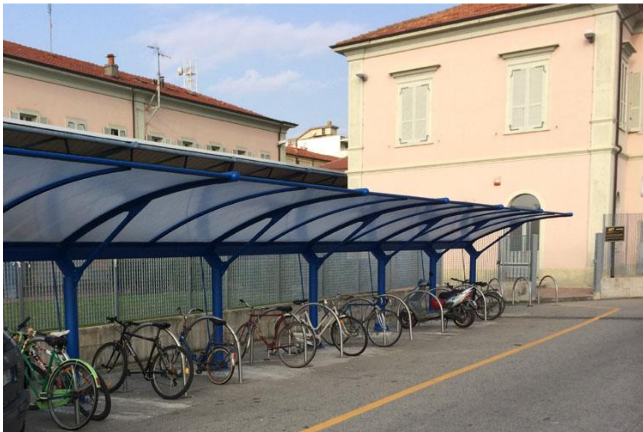
Fig. 3.2.xvii – Esempio di parcheggio coperto e videosorvegliato, comune di Rivarolo Città Metropolitana di Torino
