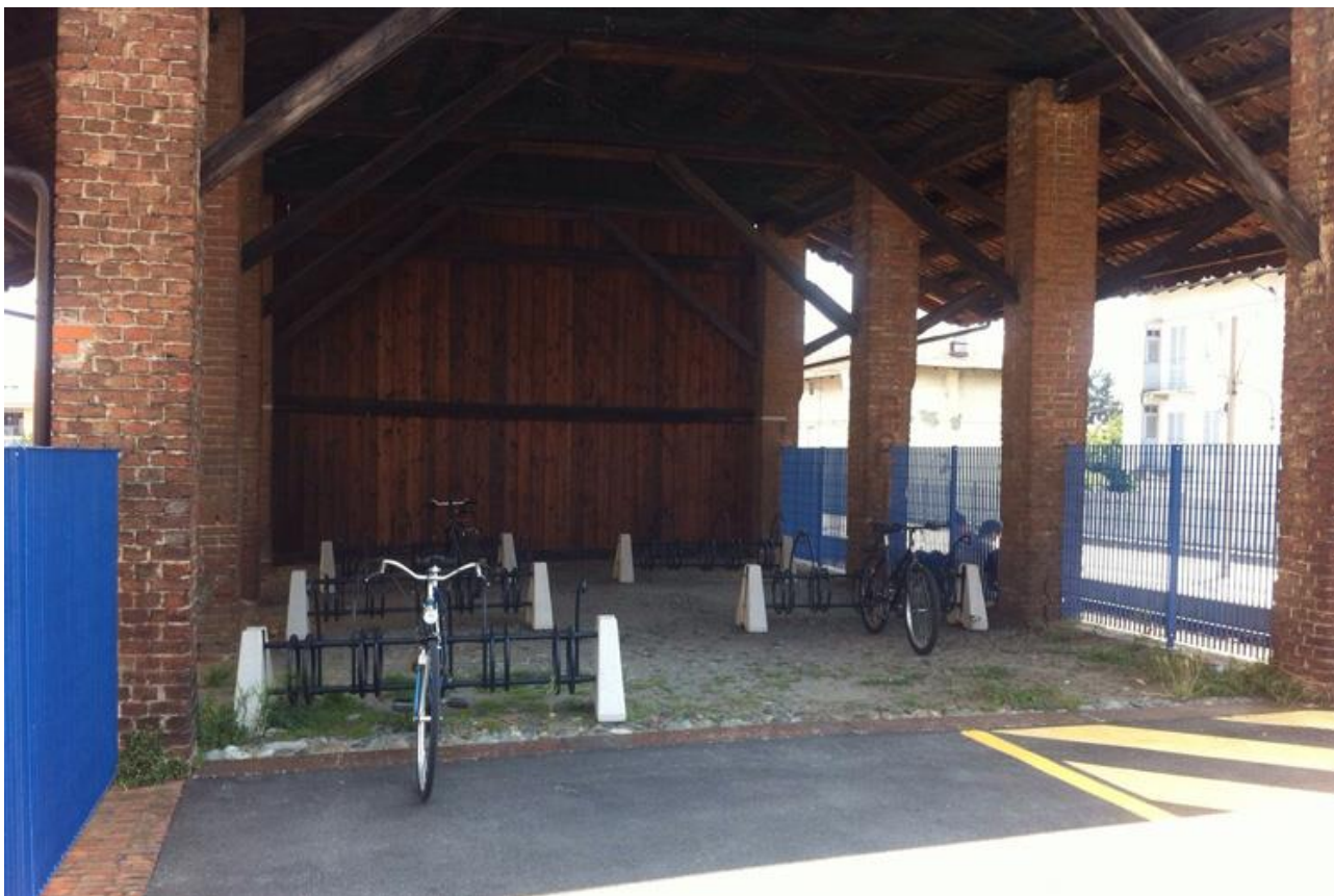
Fig. 3.2.xvi – Esempio di parcheggio coperto, comune di Nole Città Metropolitana di Torino
