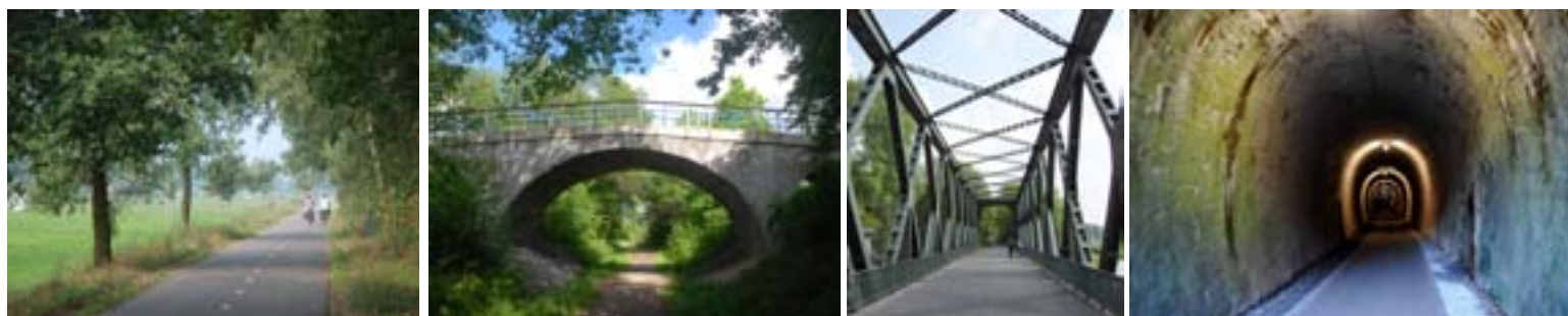
Da sinistra a destra: il percorso Winterswijk-Neede (Paesi Bassi); Falkenstein-Radweg (Baviera); un ponte della Ruhrtal-Radweg a Essen (Nordreno-Vestfalia); la galleria Hohenhainer a Freudenberg (Nordreno-Vestfalia).
