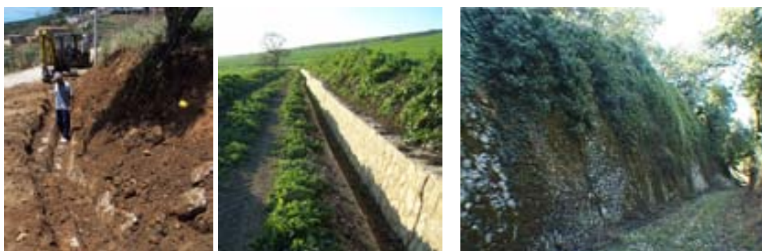
Da sinistra a destra: 31 e 32 recupero delle originarie cunette e dei muretti in pietrame e malta, sepolti a seguito del lungo periodo di abbandono; 33 muro di contenimento coperto dalla vegetazione, prima del recupero.
