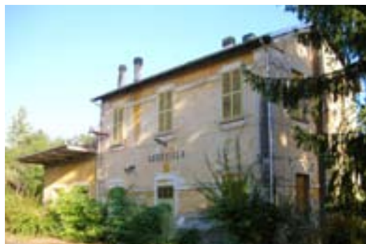
Ex stazione di Codevilla, sulla ferrovia abbandonata Voghera-Varzi, Lombardia.
