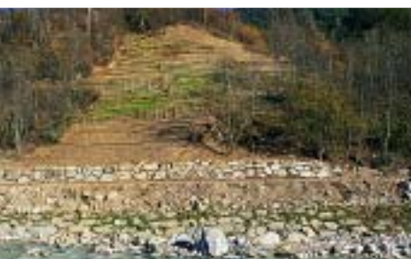
Frana Cismon. Sopra, esempio di scogliere e palificate in larice. A destra, a lavori ultimati.
