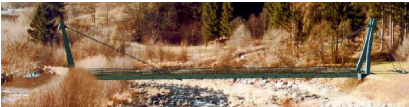
Valle Rendena. In alto, progetto di ponte strallato (ancorato con tiranti) di 60 metri sul fiume Sarca. Struttura portante in acciaio verniciato, piano di calpestio in doppio tavolato di larice. Sopra, rendering (simulazione fotografica) del ponte in località Spiazzo.
