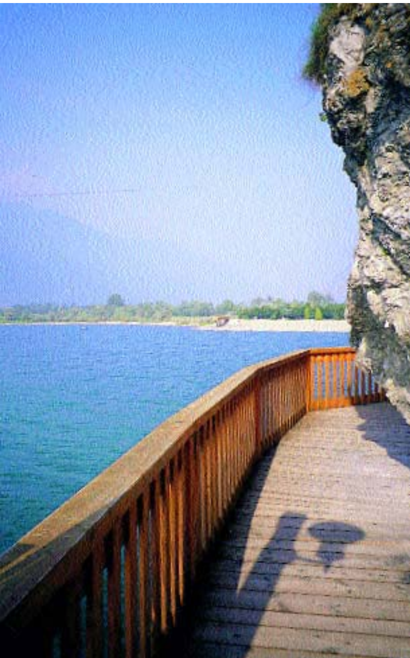
Lago d'Idro. Sopra, passerella a sbalzo in legno ancorata sulla roccia. Lago di Lédro. A destra, il percorso circumlacuale è stato realizzato in scavo/riporto e con passerelle in legno, in parte a sbalzo. La difesa spondale si avvale di tecniche di ingegneria naturalistica.
