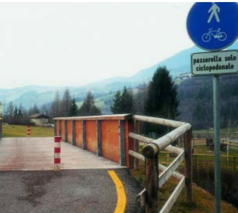
Valli di Fiemme e Fassa. Particolare di una passerella sul Rio Lagorai a Tesero con trave-parapetto in legno lamellare.
