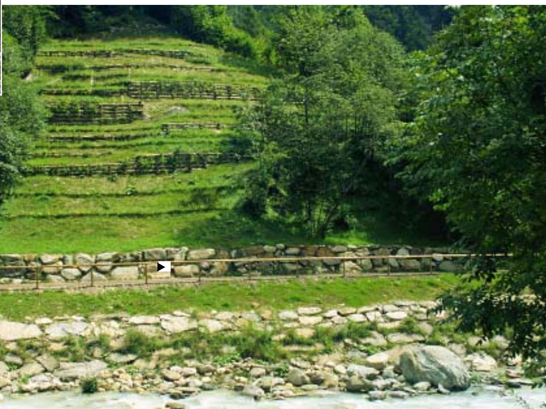
Frana Cismon. Sopra, esempio di scogliere e palificate in larice. A destra, a lavori ultimati.
