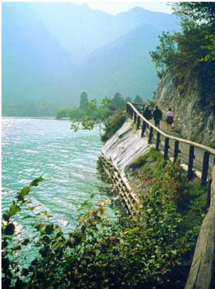
Lago d'Idro. Sopra, passerella a sbalzo in legno ancorata sulla roccia. Lago di Lédro. A destra, il percorso circumlacuale è stato realizzato in scavo/riporto e con passerelle in legno, in parte a sbalzo. La difesa spondale si avvale di tecniche di ingegneria naturalistica.
