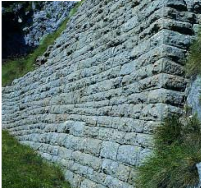
A sinistra, muro a secco o contromuro e disegno della sezione. Sopra, il tratto Strada Eroi di Pasubio. Sotto, Parco della Pace, ex caposaldo di Cima Zugna.
