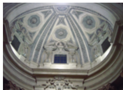
Semicalotta del braccio sinistro dell'altare dell'Assunta (in alto) e destro dell'altare di S. Lazzaro (in basso) con la decorazione in stucco dopo la pulitura, nella facies corrispondente all'intervento burattiano.
