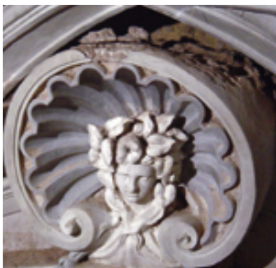
Sopra, particolare della decorazione a stucco del lanternino, con il saggio di descialbo che ha rimesso in luce la “colla brodata di color polvere di travertino” della facies cortoniana.
