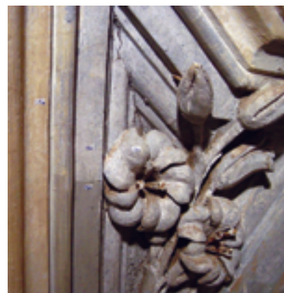
Particolare della decorazione in stucco con il motivo del giglio nella semicalotta della controfacciata, con i saggi stratigrafici eseguiti nel corso dell’intervento di restauro
