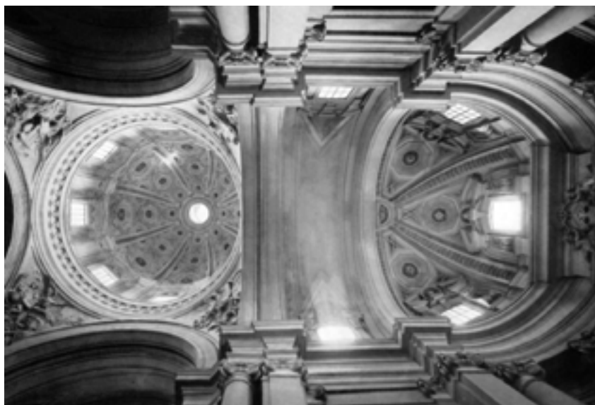
Vista degli apparati voltati della cupola, della semicalotta d'ingresso e della volta a botte interposta.
