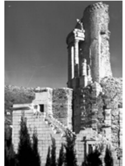
4. Il Trofeo dopo i lavori di Formigé, veduta frontale, Médiathèque de l'Architecture et du Patrimoine, foto MH0191675.
