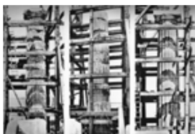
3. L'architrave in cemento armato posto da Nicolas Balanos al posto dell'arco in mattoni del 1872 (da N. Balanos, Les monuments de l'Acropole , cit.).
