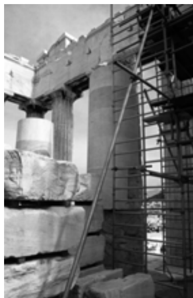
6. Le reintegrazioni cementizie ai fusti del Partenone effettuate sotto l'Eforia di Georgios Dontas negli anni Sessanta del Novecento. Foto S. Gizzi, ottobre 2002.
