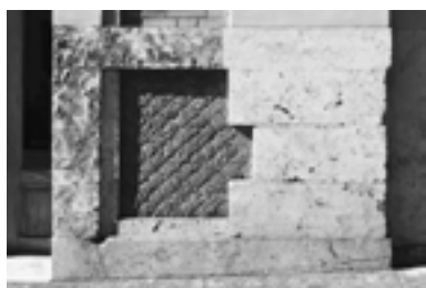
2 (a, b). Roma, Casa Giovannoni in via San Martino ai Monti 8 (1925. Roma, Archivio Storico Capitolino, Ispettorato edilizio, 28025/1925). Da notare gli inserti in opus reticulatum in selce nella prima fascia basamentale: elementi semplici e costruttivi a forte valenza evocativa che possono alludere sia alle porzioni di strutture parietali appena emerse dagli scavi di Ostia antica che, più banalmente, ai sampietrini delle strade della città. Foto D. Onorati.
