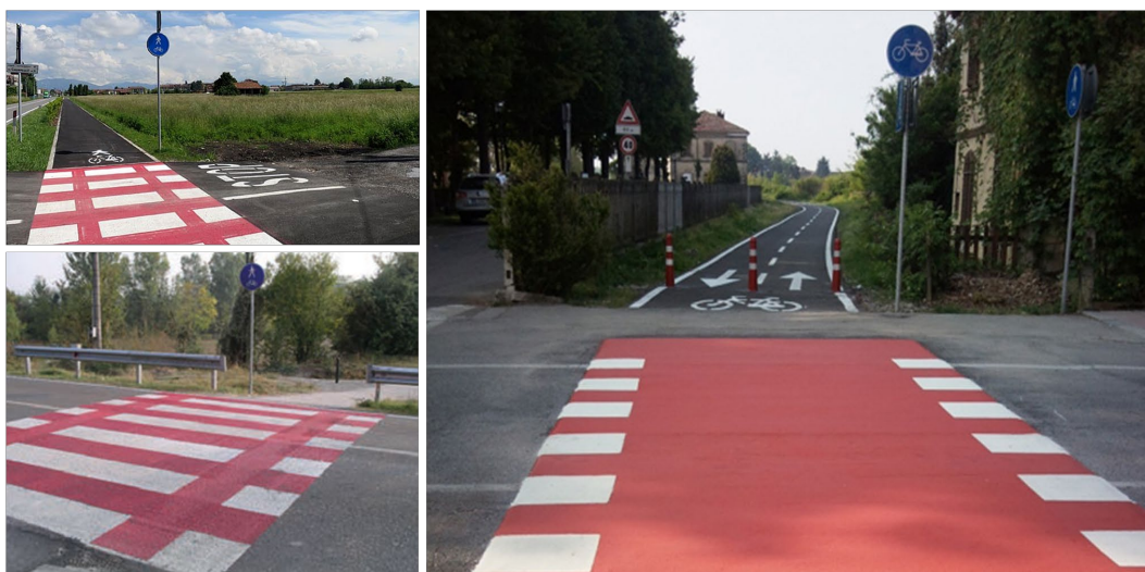
Figura 4.43 - Attraversamento ciclabile semplice (la presenza di archetti e paletti oltre l'attraversamento rappresenta un elemento di pericolosità e difficoltà di passaggio per i mezzi più ingombranti come bici con carrello, tandem etc.)
