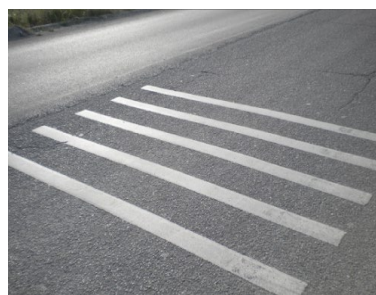
Figura 4.33 - Strisce di pavimentazione in rilievo
