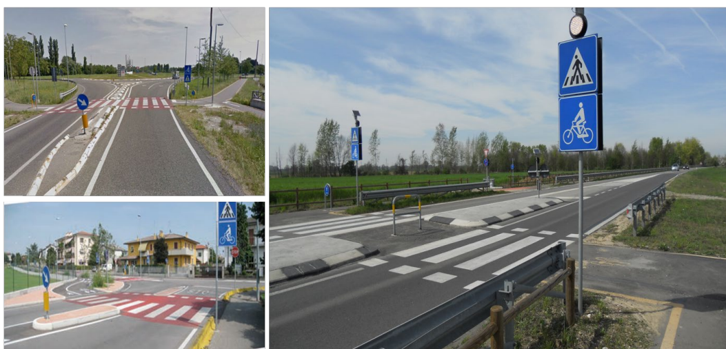
Figura 4.44 - Attraversamento con isola centrale salvagente (la presenza di archetti e paletti in corrispondenza e oltre l'attraversamento rappresenta un elemento di pericolosità e difficoltà di passaggio per i mezzi più ingombranti come bici con carrello, tandem etc.)
