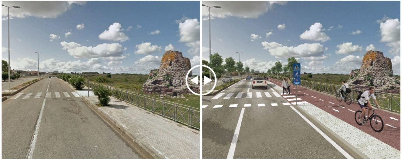
Figura 4.21 - Inserimento pista in sede propria bidirezionale affiancata al marciapiede mediante l'intervento n. 5
