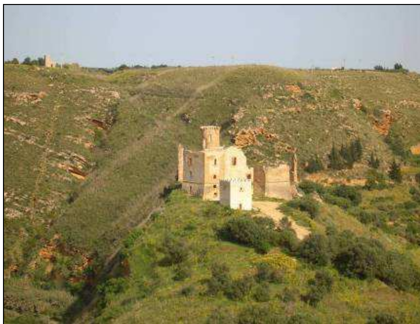
Fig. 11 - Parete rocciosa interessata da fenomeni di crollo in c.da Castello
