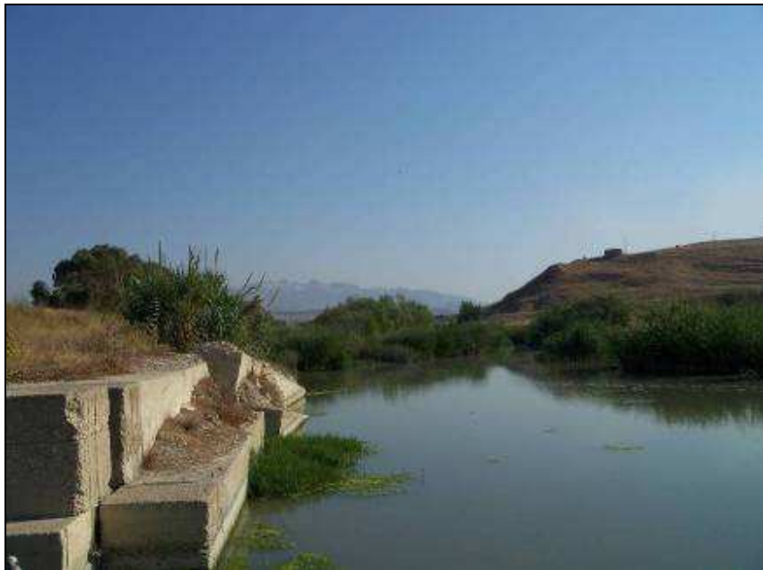
Fig. 15 - Particolare di argine in cemento armato
