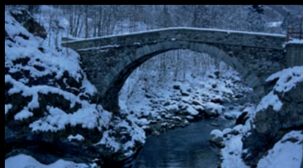
Fobello, ponte in località Oltracque
