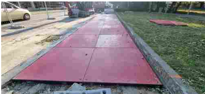
La posa dei moduli intelligenti sulla pista ciclabile in corso Europa ad Alba
