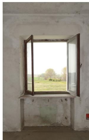
Particolare serramento appartamenti piano primo.
