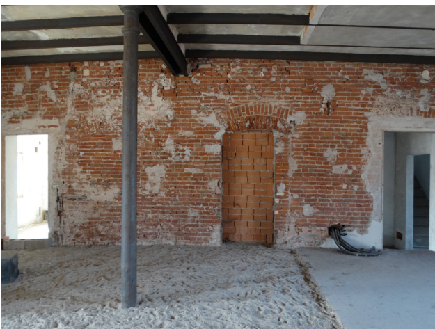
Parete che divide il nucleo originario dall'ampliamento su cui sono ancora visibili le aperture tamponate.
