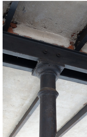
Particolare della struttura piano primo.
