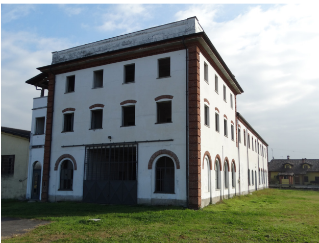
La fabbrica di fecola e destrina, il nucleo originario - fotografia scattata il 14.11.2020
