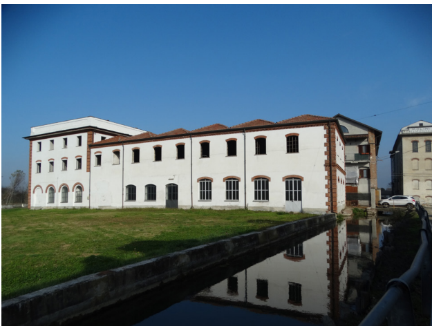
La relazione tra la fabbrica e la Bealera del Mulino, il nucleo originario (3 piani fuori terra) e l'ampliamento (2 piani fuori terra) - fotografia scattata il 14.11.2020
