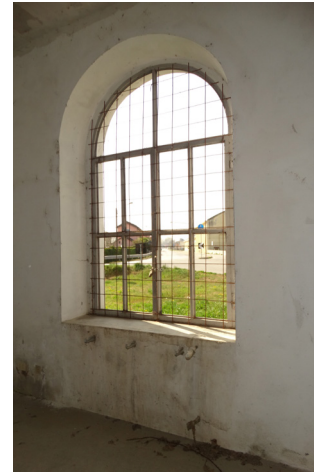
Particolare del serramento del piano terra.
