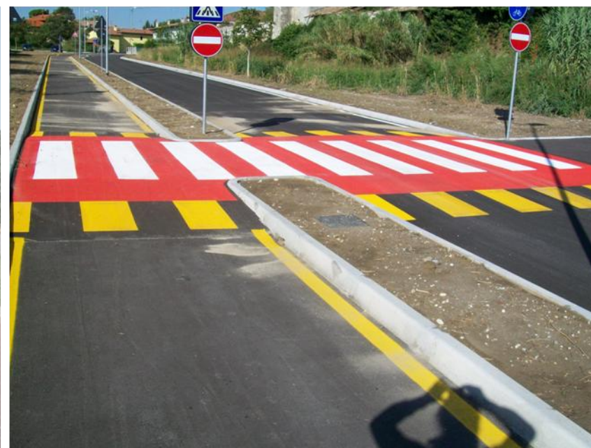
Figura 15 - Tipologia 4U attraversamento pedonale/ ciclabile urbano rialzato
