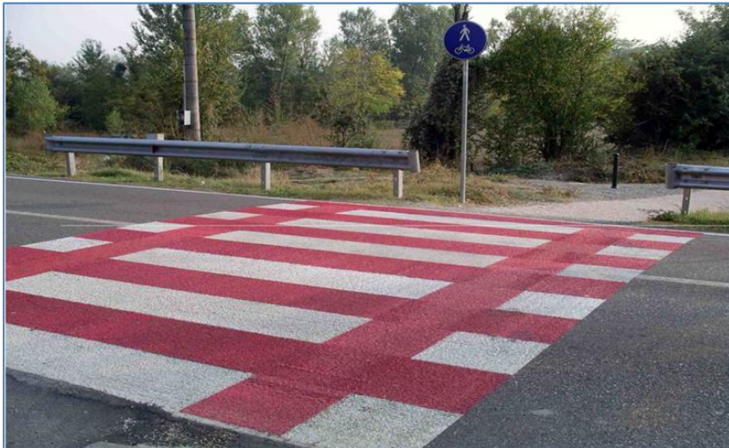
Figura 17 - Tipologia 4E - attraversamento extraurbano
