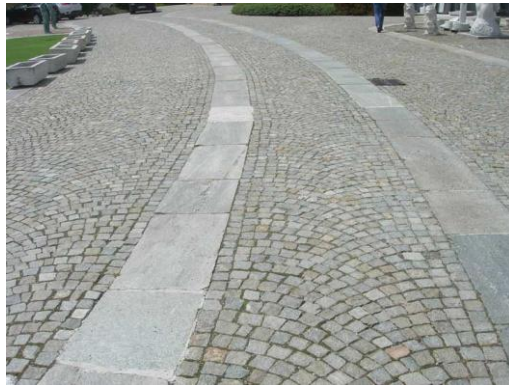
Figura 56 - Pavimentazione zone 30 in ambito urbano
