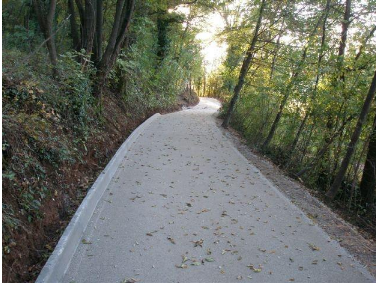
Figura 50 - Pavimentazione in stabilizzato misto cava
