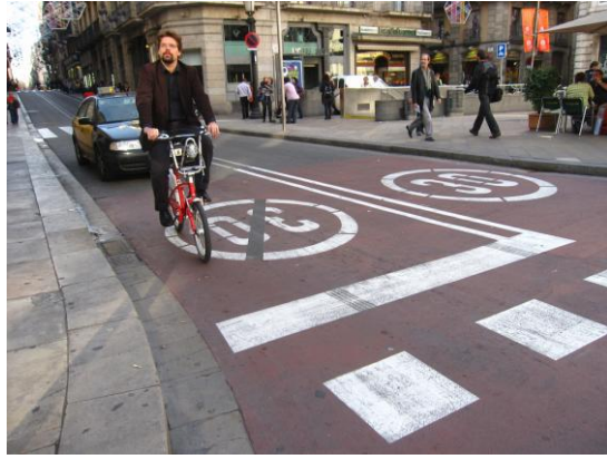
Figura 55 -Segnaletica orizzontale zone 30 in ambito urbano, colorazione pavimentazione
