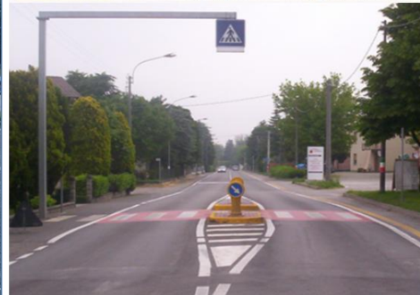
Figura 17 - Tipologia 4E - attraversamento extraurbano
