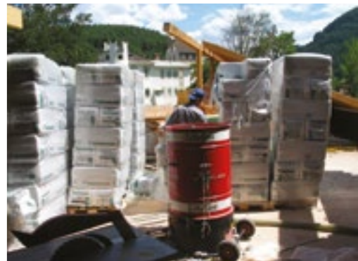
Sacchi di fiocchi di cellulosa in cantiere. (Foto studio EM2, Brunico)
