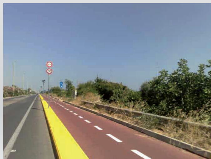
13 - Ciclabile in sede propria con cordolo di separazione
