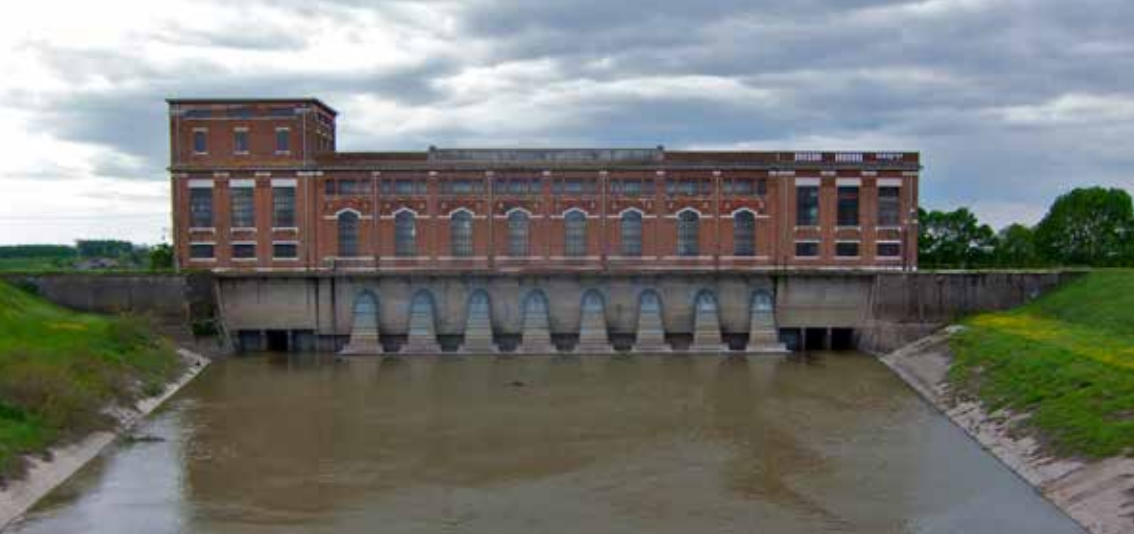
Impianto idrovoro "Mondine"
