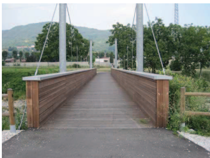
Foto n° 15 – Passerella strallata a Cornedo
