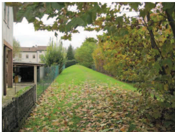
Foto n° 34 - Argine inerbato a Vivaro
