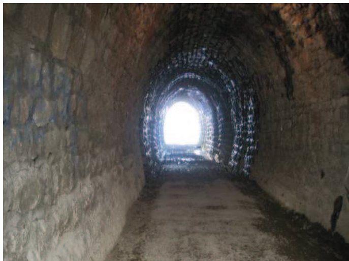
Foto n° 19 - Interno della galleria di Cesuna
