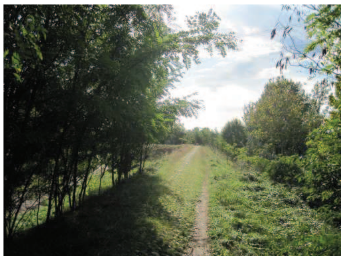
Foto n° 10 – Inizio tratto arginale a Bassano
