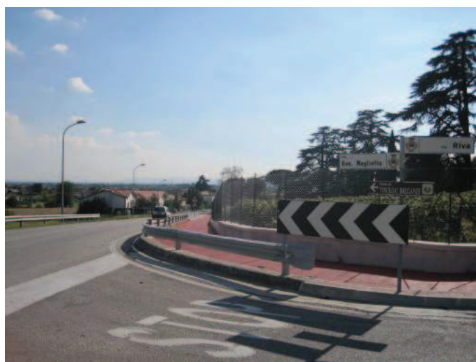
Foto n° 6 – Tratto realizzato a Breganze (lato N SP)
