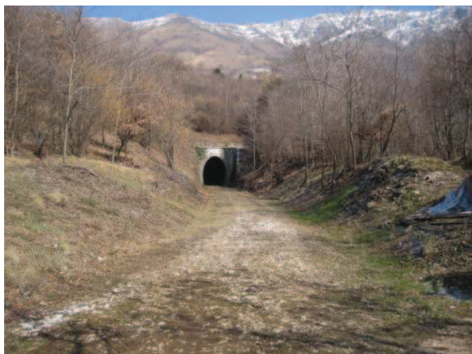
Foto n° 15 –A monte della Galleria Barricatella
