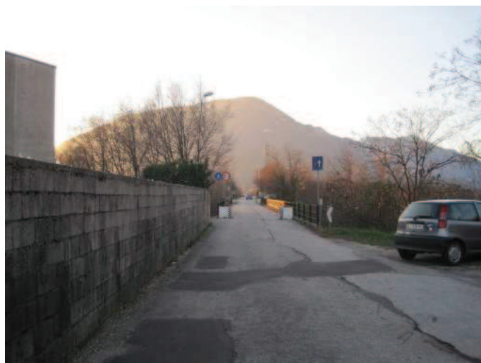
Foto n° 8 – Ponte su SP 349 a Chiuppano
