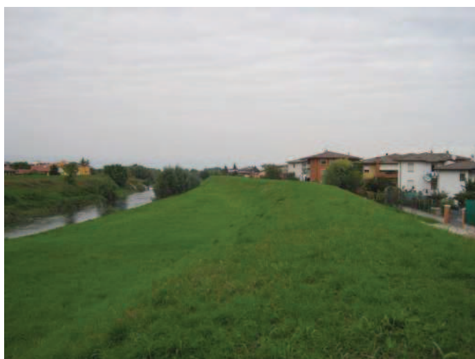
Foto n° 5 - Argine sterrato a Torri di Quartesolo
