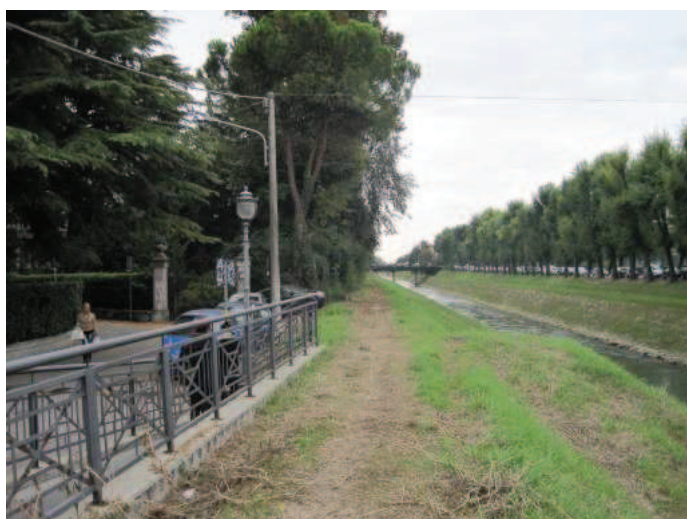
Foto n° 11 – Sommità arginale lungo Via d/Stadio
