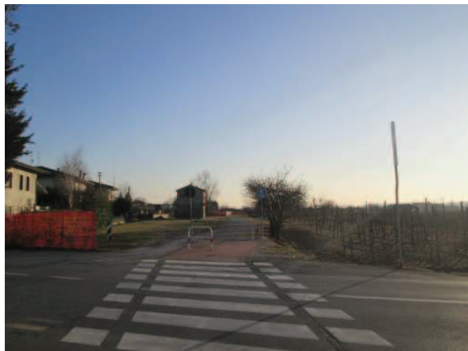
Foto n° 6 – Casello a Ponte di Castegnere
