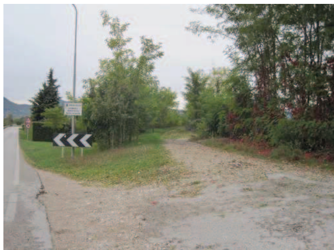
Foto n° 16 – Fine tratto sommità arginale – incrocio SP 49
