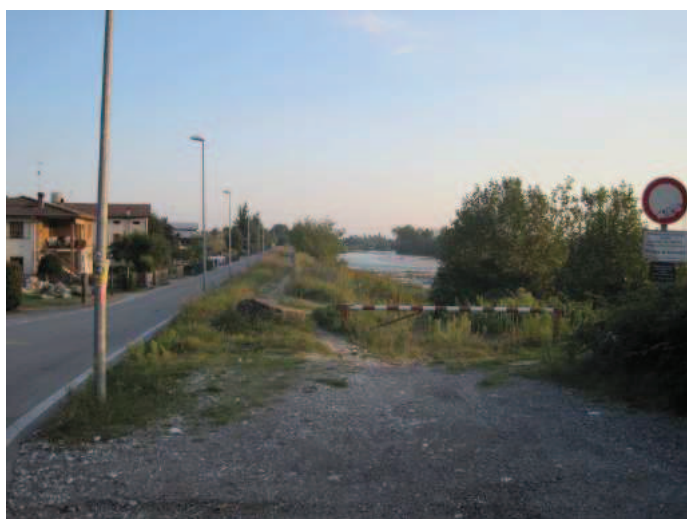
Foto n° 17 – Tratto arginale a Tezze
