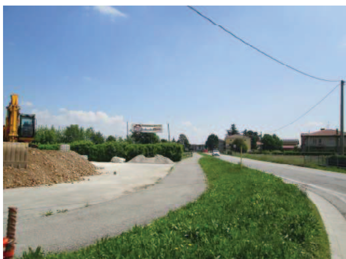
Foto n° 17 – Sede propria asfaltata a Poiana d.G.
