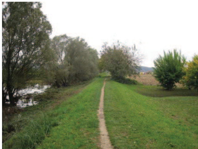
Foto n° 14 – Tratto in sommità arginale del Retrone
