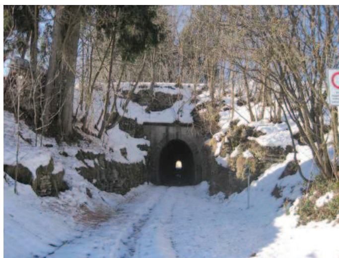
Foto n° 18 – Ingresso nord galleria di Treschè Conca
