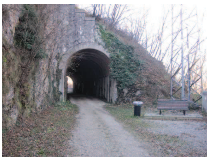
Foto n° 24 – Galleria e area di sosta
