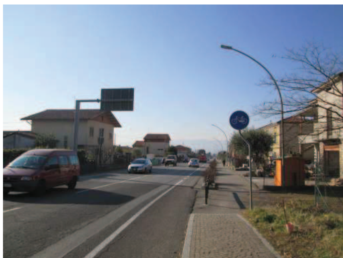
Foto n° 5 – Sede propria a Piovene R.
