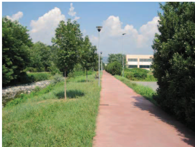
Foto n° 8 – Pavimentazione asfaltata colorata
