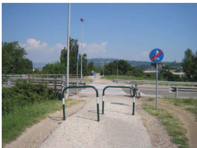
Foto n° 5 - Attraversamento di Via del Commercio
