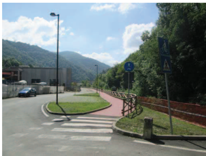
Foto n° 18 – Itinerario in sede propria ad Altissimo
