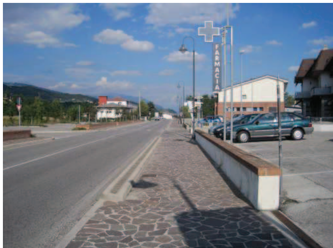
Foto n° 7 – Pavimentazione asfaltata colorata
