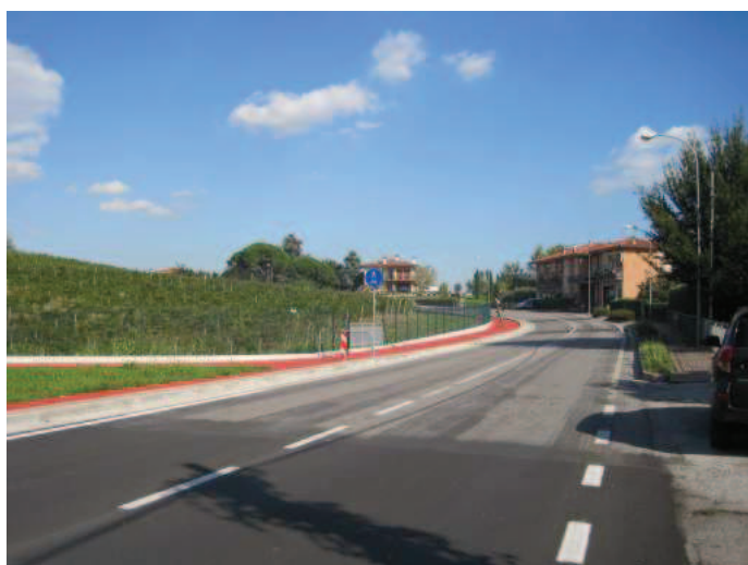
Foto n° 5 – Tratto realizzato a Breganze (lato N SP)
