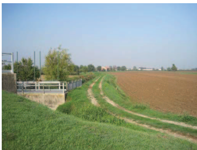
Foto n° 5 – Opere di presa C. LEB e inizio TV Ostiglia
