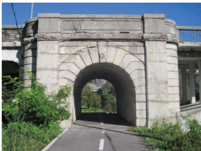
Foto n° 3 – Sottopasso ponte per Primolano
