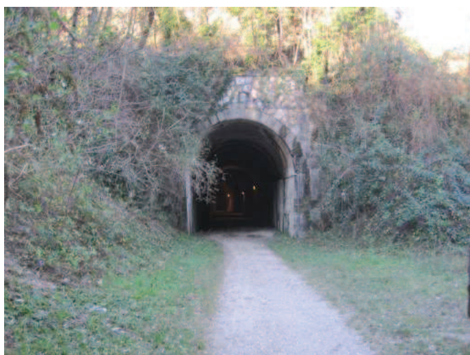
Foto n° 23 – Tratto in galleria a Piovene R.
