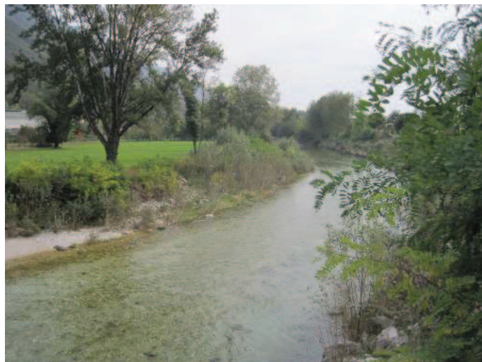
Foto n° 14 - Argine sterrato a sud di Schiri
