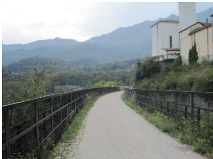
Foto n° 28 – Inizio ponte su T. Posina ad Arsiero
