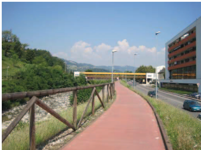
Foto n° 7 – Pavimentazione asfaltata colorata
