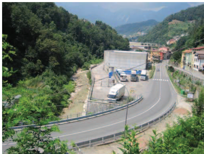
Foto n° 2 – SP 246 alle porte di Recoaro
