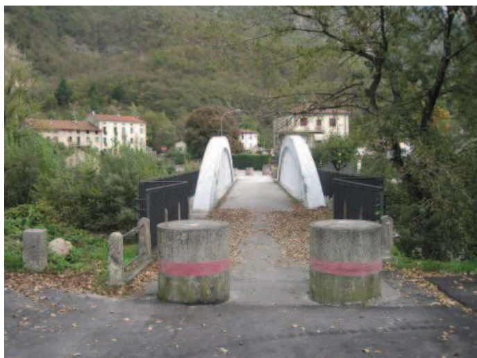
Foto n° 15 - Ponte ferroviario dismesso a Schiri
