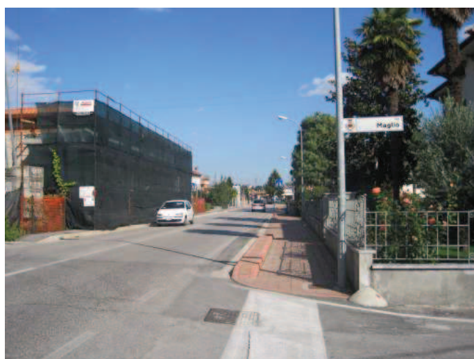
Foto n° 4 – Tratto realizzato a Breganze (lato S SP)
