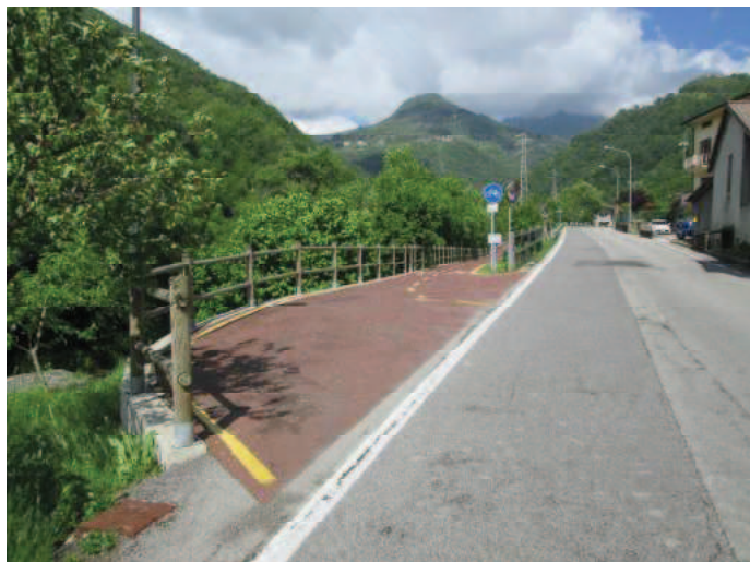
Foto n° 19 - Itinerario in sede propria a Crespadoro
