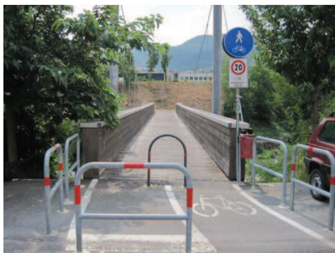
Foto n° 12 – Passerella in Z.A. Valdagno-Cornedo
