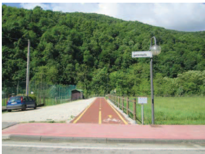
Foto n° 17 – Itinerario in sede propria ad Altissimo
