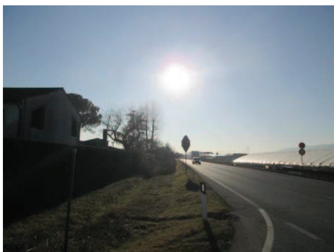
Foto n° 11 – Tracciato lungo viabilità complem. A31
