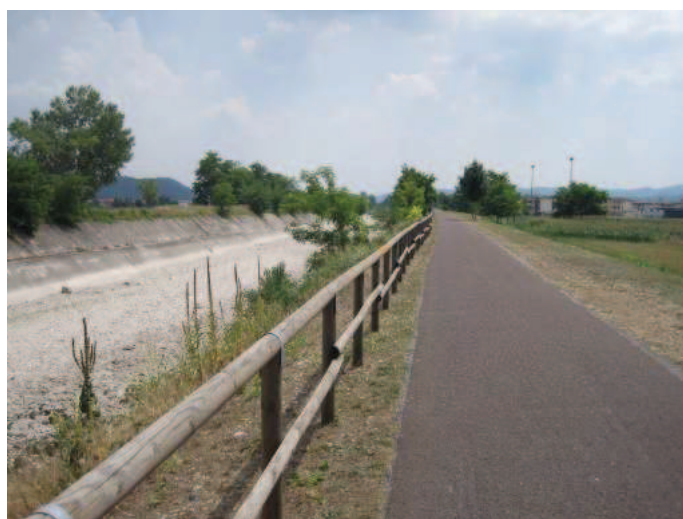
Foto n° 18 – sede propria in dx idrogr. a Brogliano
