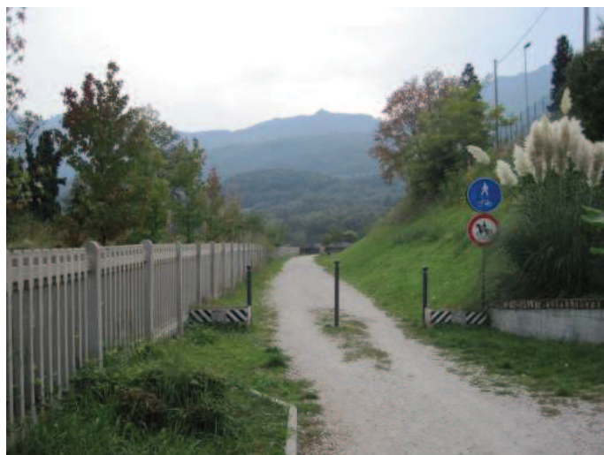
Foto n° 16 - Sede propria ad Arsiero (Ex Ferr. Stor.)
