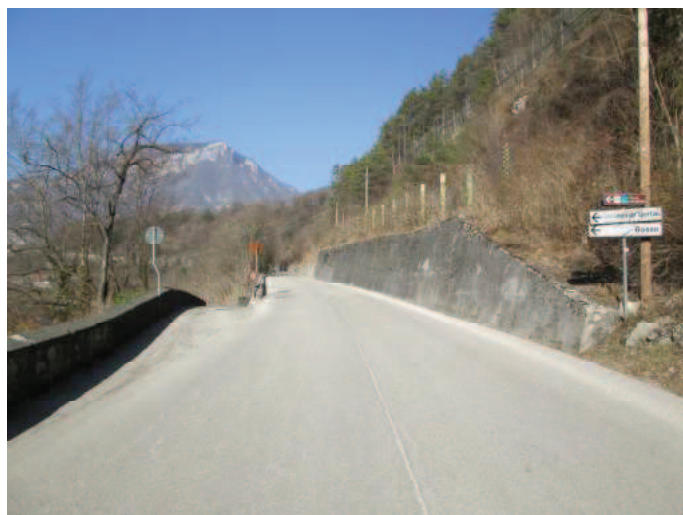
Foto n° 26 - Sede stradale promiscua (prov./vic.)
