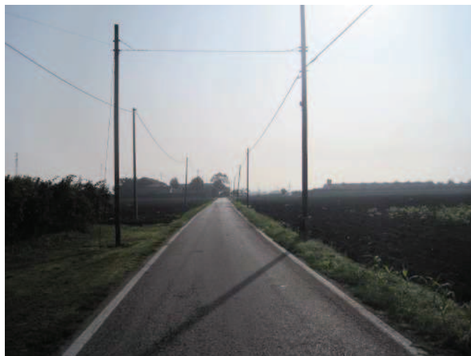
Foto n° 2 – Sede stradale promiscua a Lonigo
