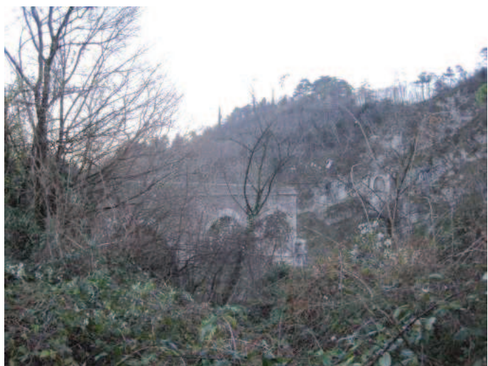
Foto n° 11 – Ponte interrotto su T. Astico
