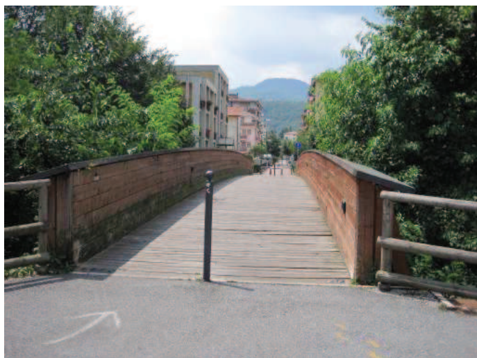
Foto n° 9 – Passerella per attraversamento T. Agno
