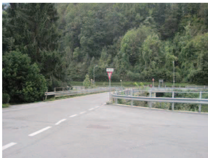
Foto n° 4 – Ponte tra Maso Fondi e Facchini Dx
