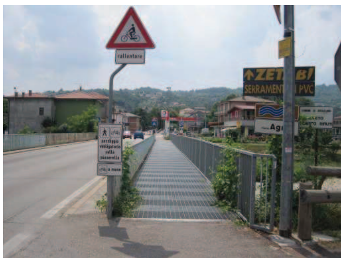
Foto n° 17 – Passerella a lato del ponte lungo SP39
