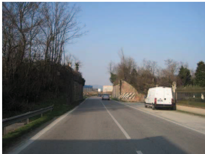
Foto n° 8 – Sovrappasso (crollato) della Riv. Berica
