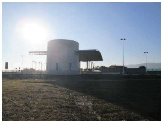
Foto n° 10 – Intersezione con A31 - Longare
