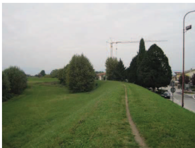
Foto n° 6 - Argine sterrato a Marola
