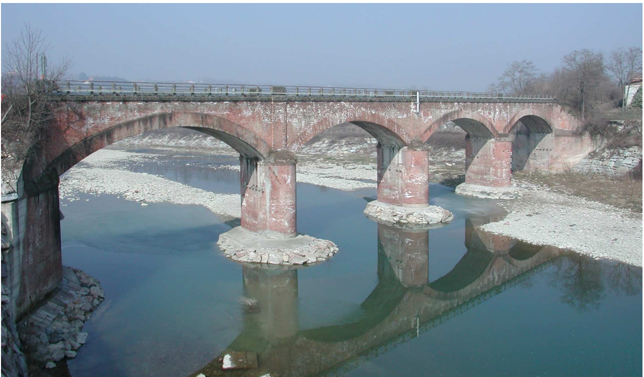
FIGURA 42: Ponte sul fiume Tanaro al km 69+214
