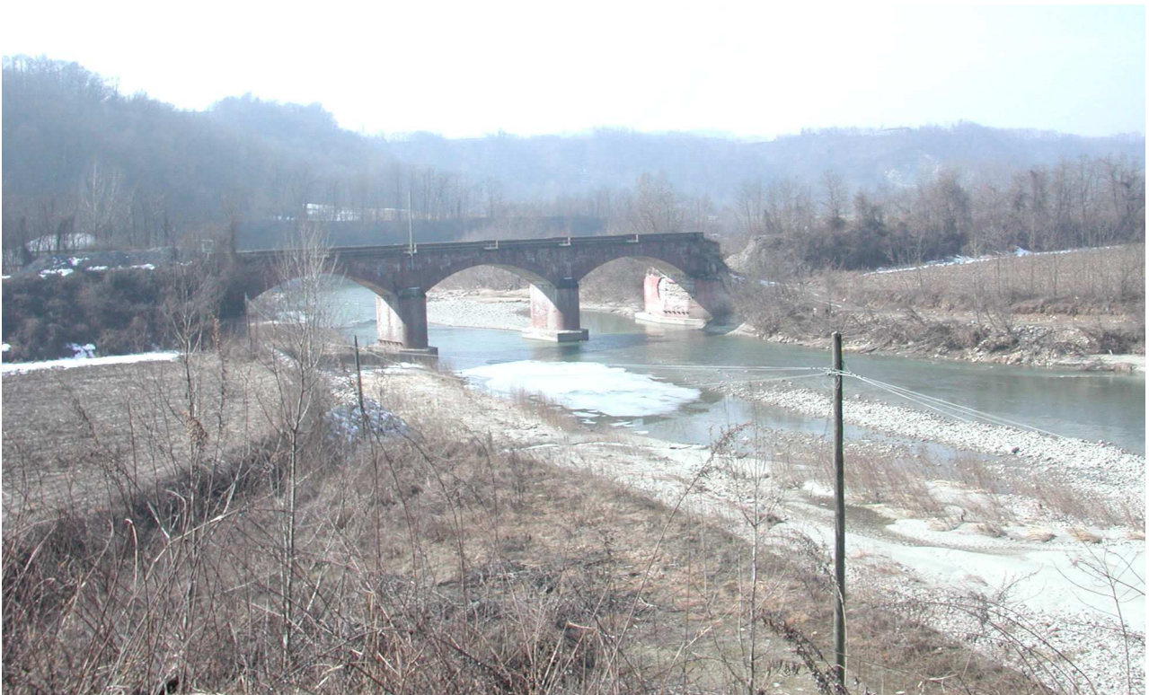
FIGURA 70: Ponte sul fiume Tanaro, al Km 57+529,52, a tre campate di m. 20,00
