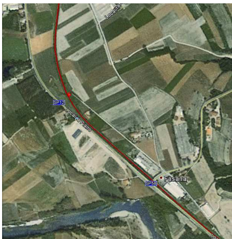
FIGURA 19: Ex tracciato ferroviario
