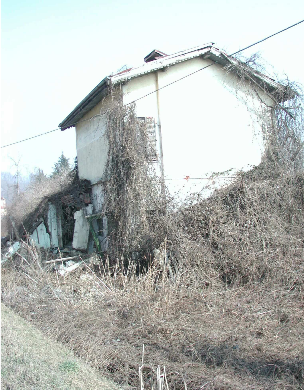
FIGURA 54: Casa Cantoniera al Km 65+600, Foglio 15, part. 314
