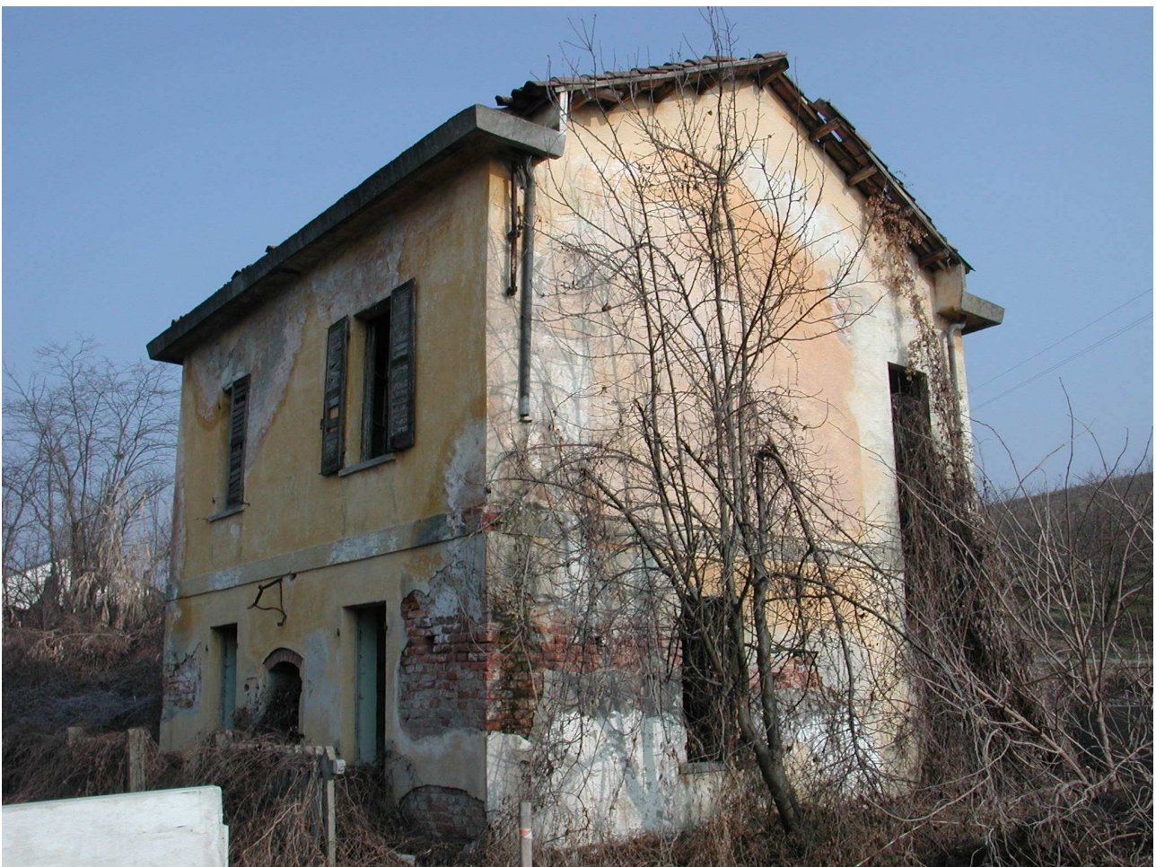
FIGURA 16: Ex tracciato ferroviario
