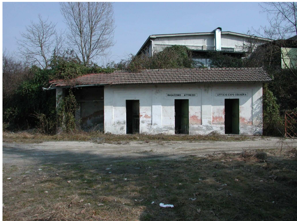
FIGURA 41: Fabbricato di stazione adibito a deposito
