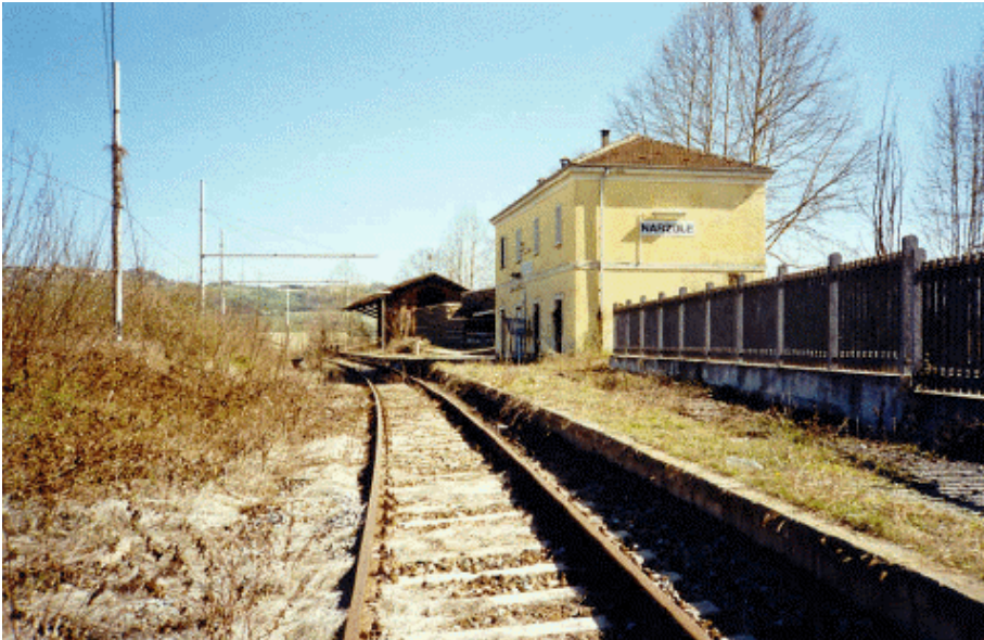
FIGURA 7: Fabbricato Viaggiatori e Magazzino Merci detto "piccola"
