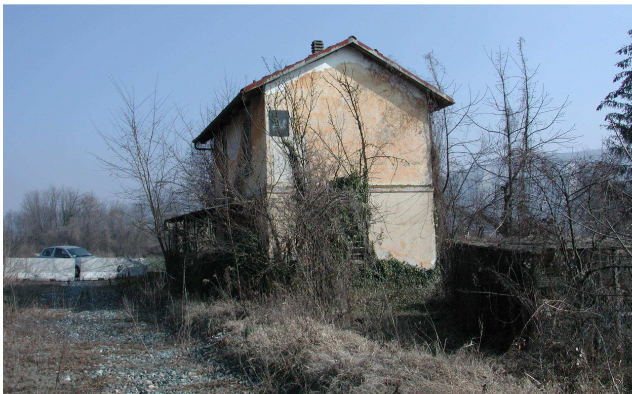
FIGURA 46: Casa Cantoniera al Km 67+288, Foglio 2, part. 44
