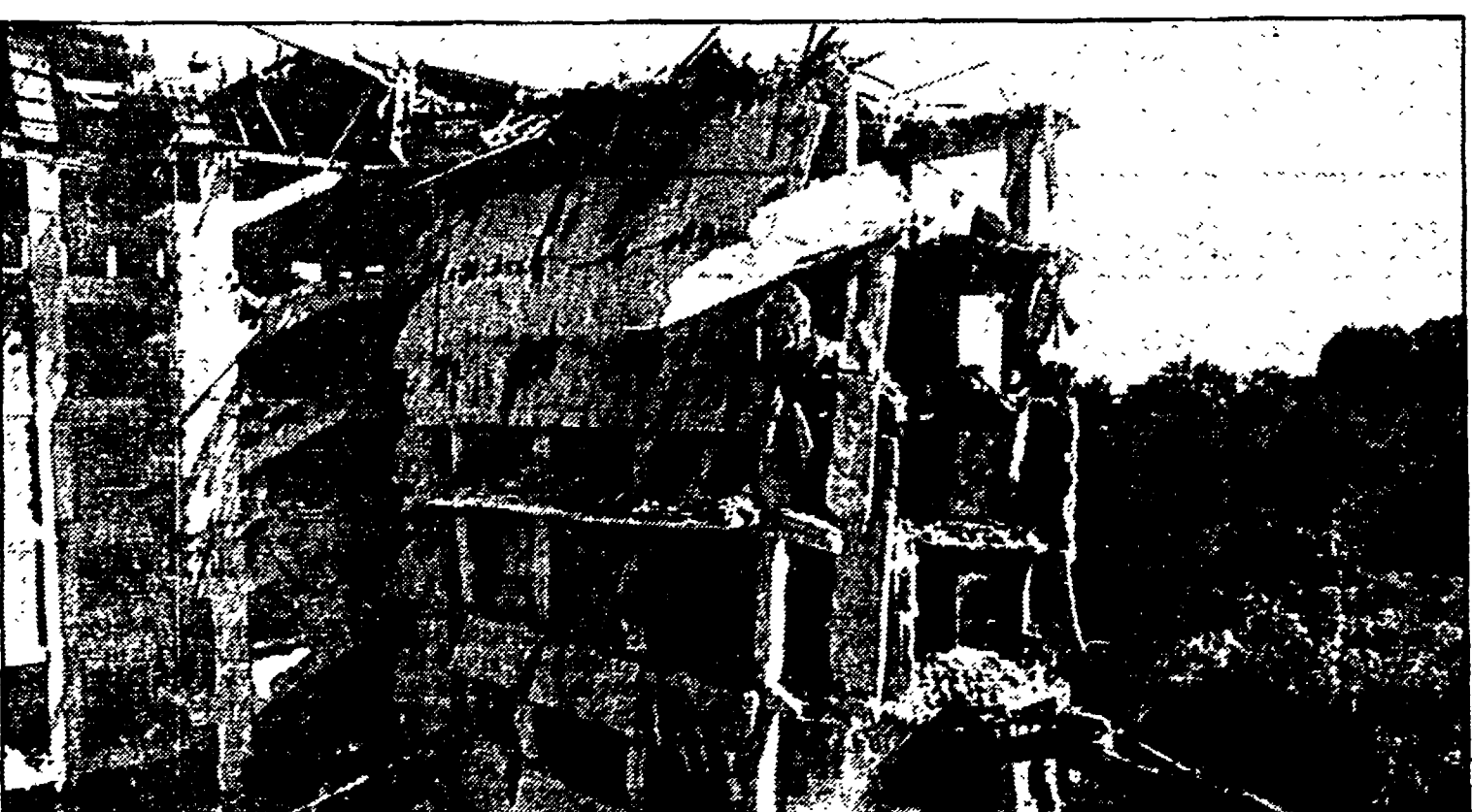
Mentre permane il caos sul condono edilizio e il governo non riesce a decidere sul da farsi, a Napoli sono stati abbattuti dai Comuni due edifici fuorilegge di sette piani ciascuno, uniti tra loro a forma di «L» per complessivi trenta appartamenti e del valore di oltre un miliardo. I palazzi erano sorti a Chiaiano, un quartiere sulla parte orientale della collina dei Carmalofoli. I due edifici, sequestrati nell'85 perché costruiti in zone con vincoli paesaggistici, erano di proprietà di un prestanome di un boss camorristico della zona
